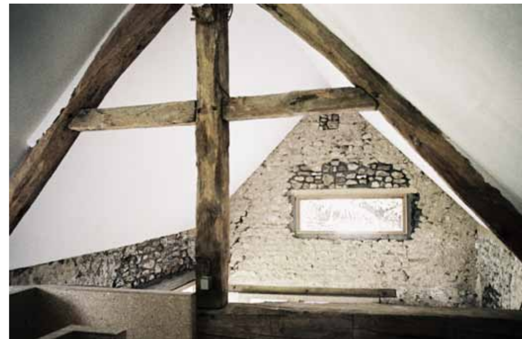
Vue intérieure Saint Étienne sous Bailleur (27)
