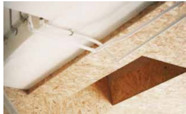
- Vue de la trémie depuis l'étage - Vue de la trémie depuis le rez-de-chaussée Bagnolet (93)
