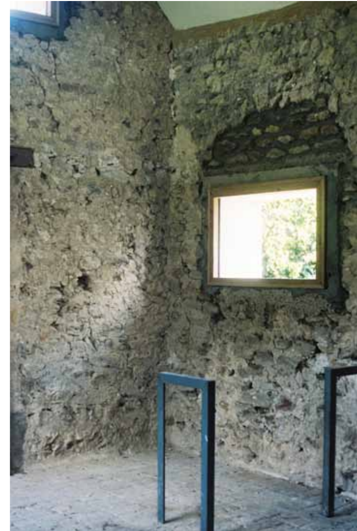
Vue et embrasure de fenêtre avant pose du vitrage Saint Étienne sous Bailleul (27)
