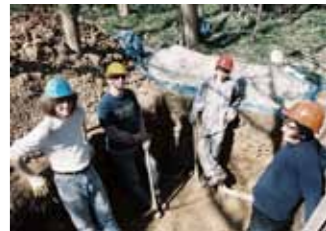
- Étudiants dans la fosse de fondation réalisée - Vue du plafond de la Folie avant la pose de toiture - Vue de la pose de l'isolation dans les murs - Vues de la construction réalisée Coupigny (27)
