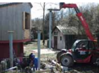
- L'escalier de la salle d'eau - La réception des poteaux - Le séchage du radier - La pose des poteaux Coupigny (27)
