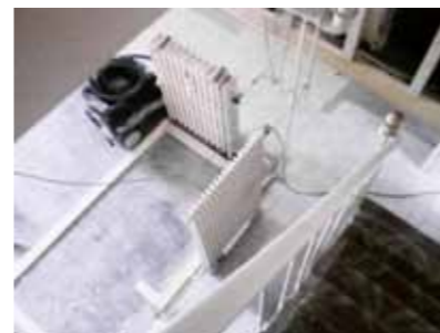
Conservation de la tuyauterie de chauffage laissée flottante par la démolition des murs Bagnolet (93)
