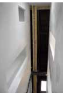
Vues de chantier sur le vide et les réserves accueillant les futurs volumes de rangements suspendus
