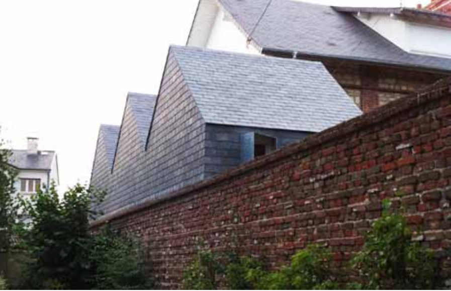
Vue depuis l'extension réalisée depuis la rue Vernon (27)
