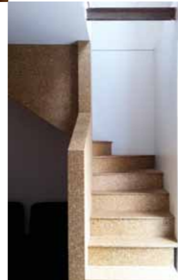
Vue sur le nouvel escalier Croissy sur Seine (78)
