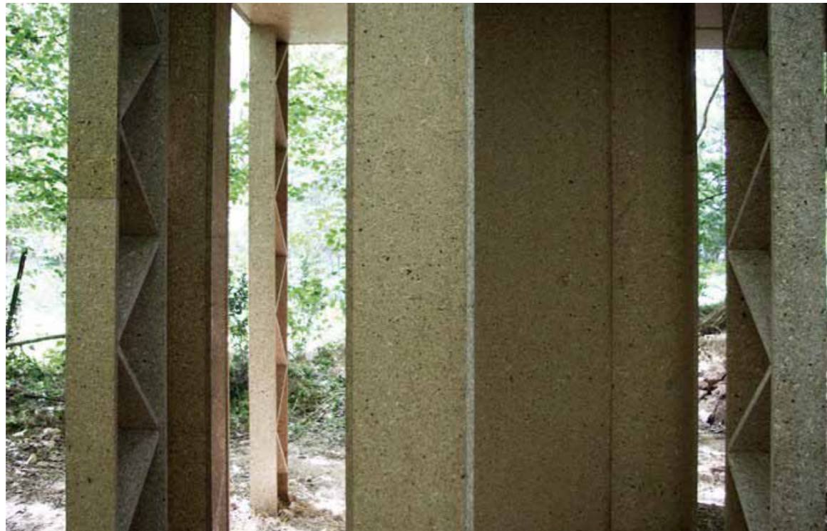
Vue de la construction réalisée Coupigny (27)
