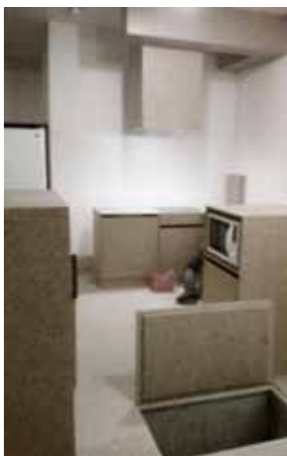
- Fabrication des socles - Cuisine de M. et Mme L. Vue sur le cellier au premier plan Antony (92)
