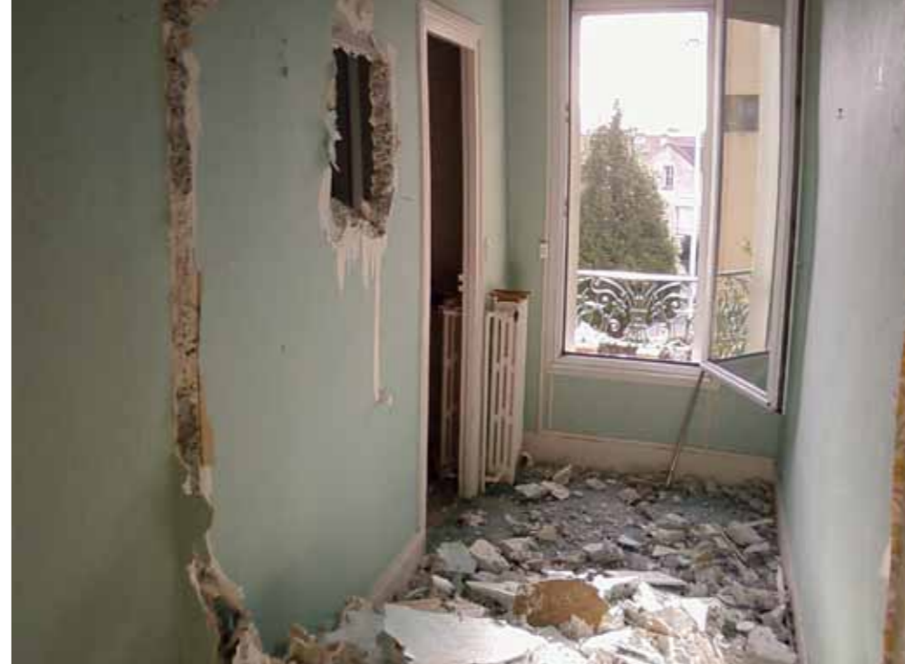
Premier jour de la phase de démolition Bagnolet (93)
